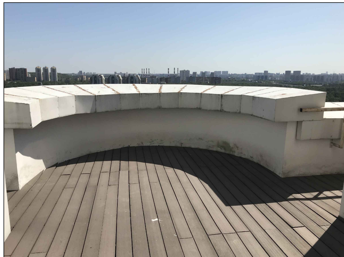
Терраса пом.3. Вид 1.
