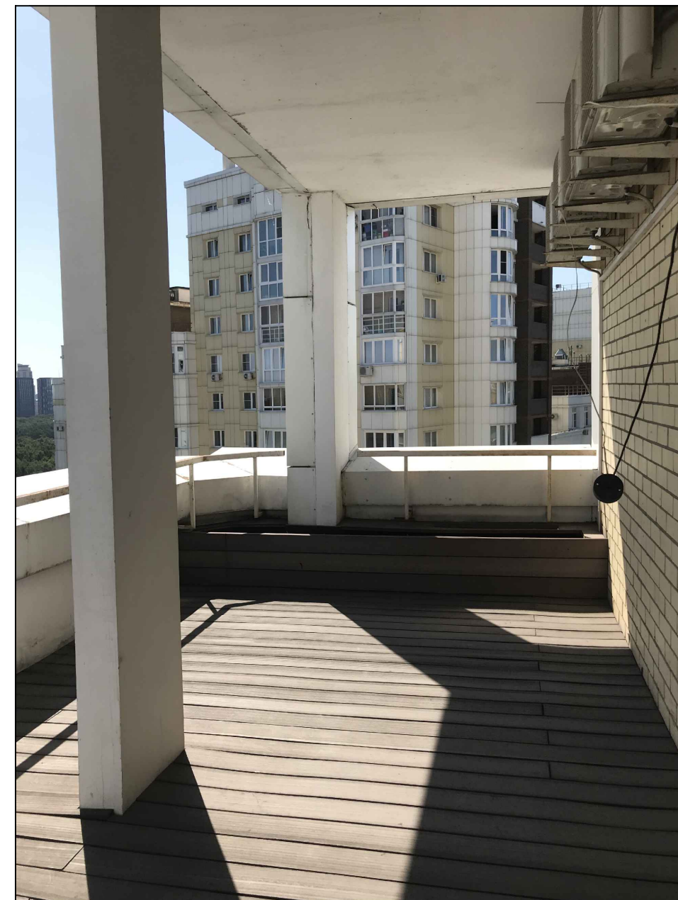
Терраса пом.3. Вид 3.
